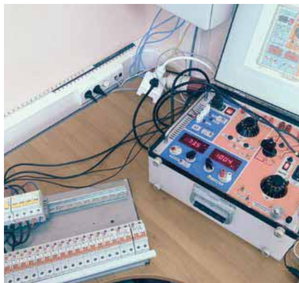
Фото 3. Стенд проверки модульного оборудования защиты
